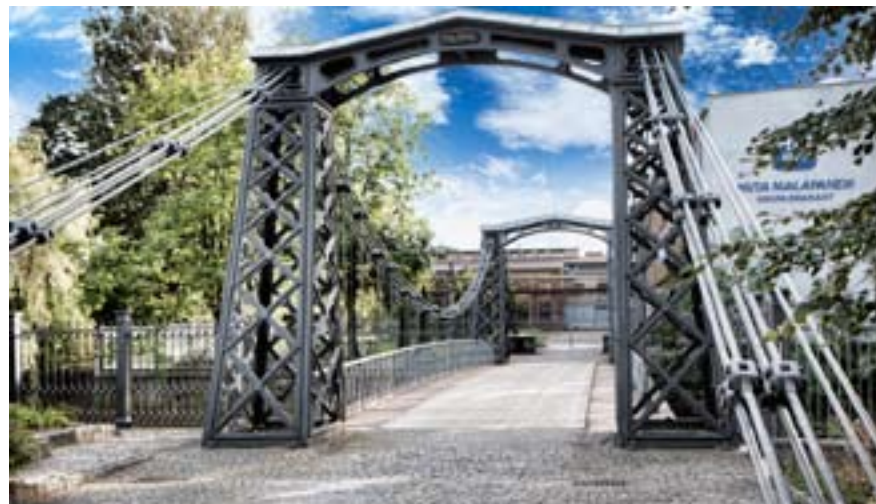
Fot. Most żeliwny w Ozimku jest pomnikiem historii architektury. Wybudowany w 1827 roku jest najstarszym w Europie kontynentalnej żelaznym mostem wiszącym.
